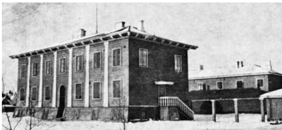
Etelä-Pohjanmaan suojelukuntapiiriin esikunnan talo Seinäjoelle joskus 1930-luvulla. Tänäpäin Suojeluskuntamuseona toimiva rakennus on kerrostalojen ympäröimä.
