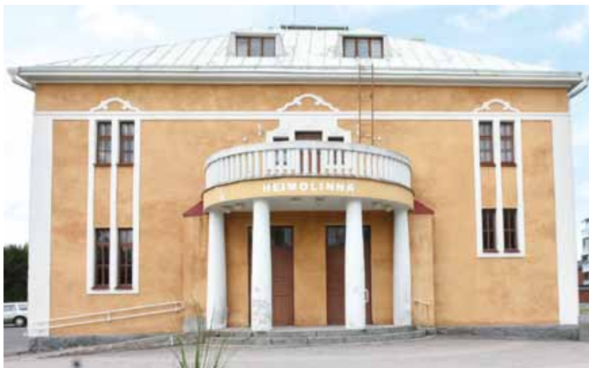
Heimolinna nykyasussaan. Talo on ulkoisesti nyt hyvässä kunnossa sisältä ja ulkoa. Valitettavasti sk-ajan sisäesineistö on hävinnyt.
