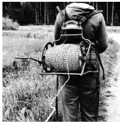
Viestimiesten näkyvin rooli ulkopuolisille oli puhelintapsin vetäminen.
