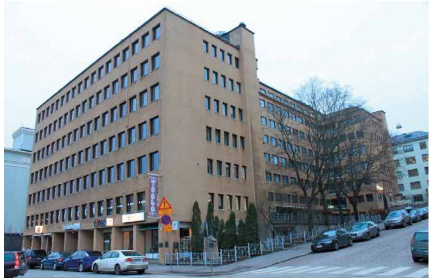
Töölöntorin suunnasta otetussa kuvassa näkyy Maanpuolustustalon H-kirjaimen muotoinen rakennus.
