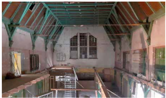
Katon komeat puurakenteet odottavat pelastustaan.
