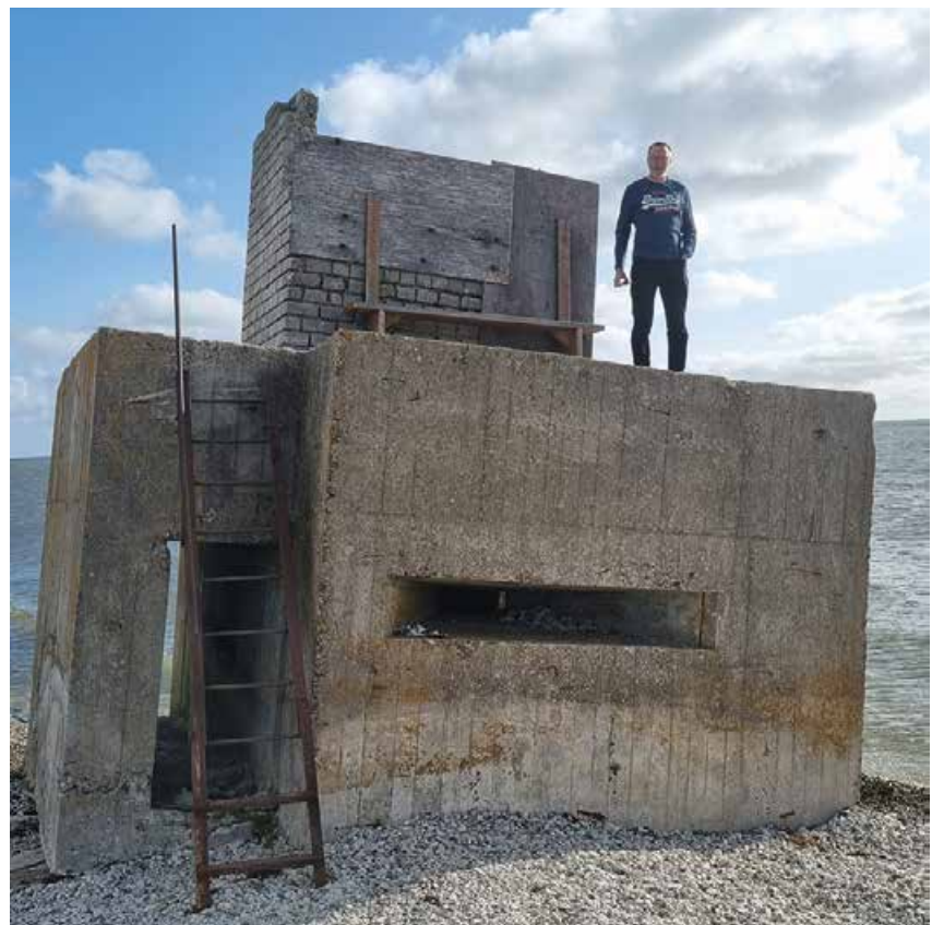
Sörven niemellä sijaitseva tähystys- ja suoja-asema.
